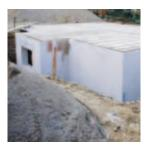
Meist sind Keller unbeheizt – deshalb sollten sie gut gedämmt sein. Mit hochwärmedämmenden Ytong Deckenplatten lassen sich Energieverluste auf ein Minimum reduzieren. Die Decken sind sofort begehbar, was
