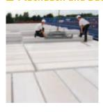
Für Flachdächer und Dachterrassen bietet Ytong ein System aus tragenden Ytong Dachplatten und passender Dämmung mit Ytong Multipor. So entstehen energieeffiziente und sofort begehbare Dächer und Terrassen, die allen
