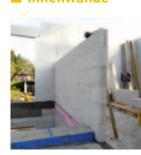
Innenwände lassen sich schnell und einfach mit Ytong Porenbeton erstellen. Ytong Porenbeton eignet sich auch hervorragend für den nachträglichen Einbau von massiven, nichttragenden Trennwänden.
