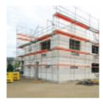
Mit Ytong Porenbeton lassen sich hochwärmedämmende Außenwände realisieren – monolithisch und ohne Zusatzdämmung. Das perfekt abgestimmte System macht diese Bauweise zu einer der wirtschaftlichsten,
