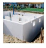
Kelleraußenwände werden monolithisch aus Ytong Porenbeton gebaut. Beste Wärmedämmung und Statik sind so optimal kombiniert. Auch Kellerinnenwände werden leicht und schnell aus Ytong Porenbeton gebaut.
